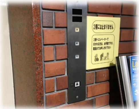
エレベーター（1階エレベーター（2階） ・2階に停まらないので、奥のエレベーターまで移動しなければならない
